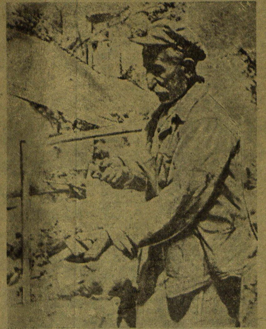
Полвека назад каменщик Даниил Ваньянц, тогда молодой человек, строил здание школы № 6. Сейчас тов. Ваньянцу 75 лет, но он еще бодр и полон сил. Теперь ему приходится восстанавливать здание этой же школы. Он выполняет нормы по бутовой кладке на 160 процентов. На снимке старший каменщик Пятигорска Д. М. Ваньянц. Фото В. Зильберга.
